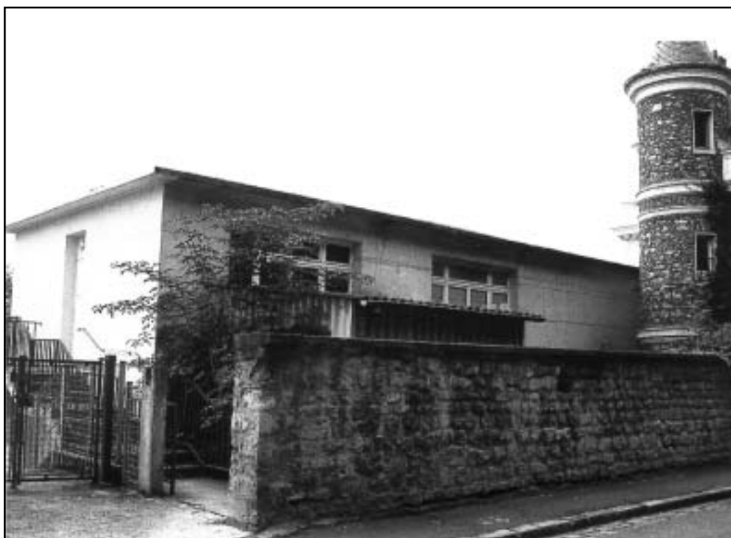
▲ 3 bis, rue Jean-Paul Soutumier à Pontoise Premier local de la prévention spécialisée
